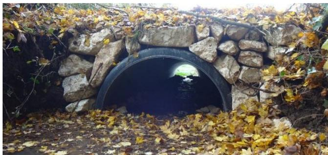
Ce système permet de ne pas intervenir dans le lit du cours d'eau mais modifie le profil des berges. Le tuyau PEHD est donc coupé en deux dans le sens de la longueur, ce qui permet de conserver un fond du lit naturel. Après la pose du tuyau, un remblai de tout-venant grossier est effectué entre la berge et la paroi du tube.
