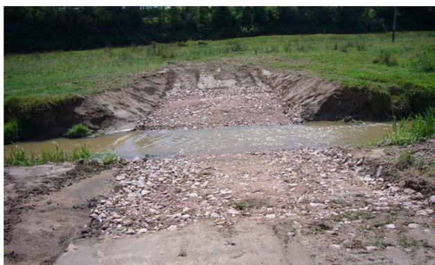
La mise en place d'un passage à gué est plutôt destinée au passage du bétail. Sa réalisation nécessite d'intervenir dans le lit du cours d'eau et sur les berges, il doit également laisser libre le passage des poissons.
